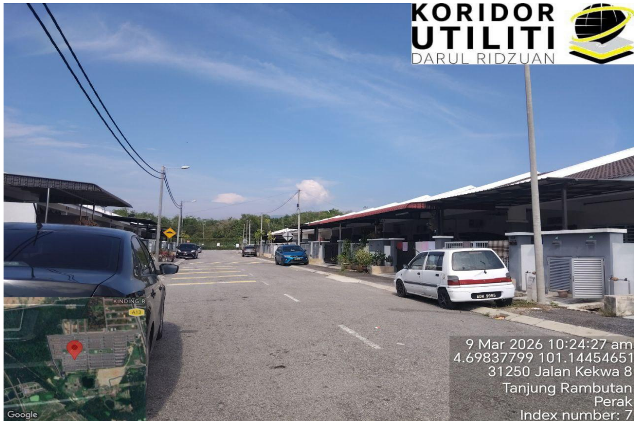
LOKASI KERJA PENANAMAN TIANG DI JALAN KEKWA 7
