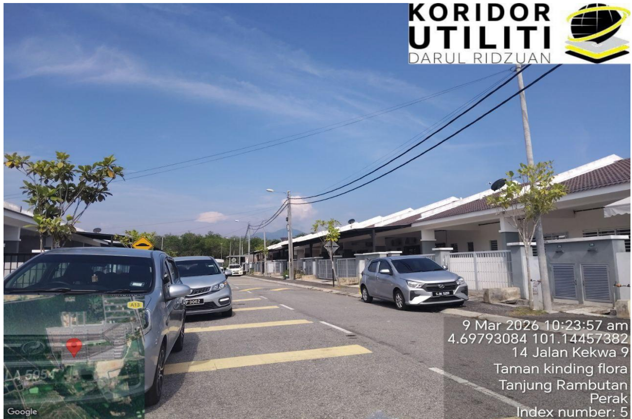
LOKASI KERJA PENANAMAN TIANG DI JALAN KEKWA 8
