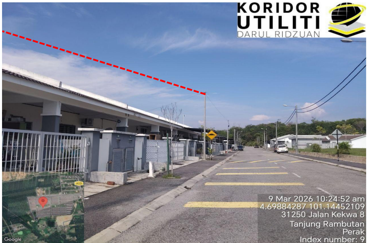
LOKASI KERJA PENANAMAN TIANG DI JALAN KEKWA 6
